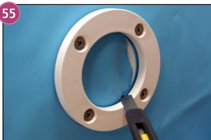
Effectuez la découpe de la buse de refoulement. A l'aide d'un cutter, découpez soigneusement le liner en vous appuyant sur l'intérieur du corps de buse.
