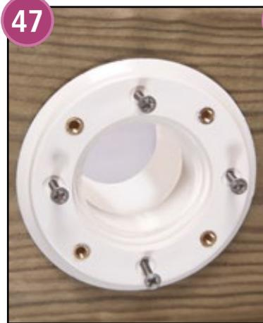
Placez, côté bassin, le corps de buse (Pack pièces à sceller) du refoulement dans l'orifice de la paroi percée.
