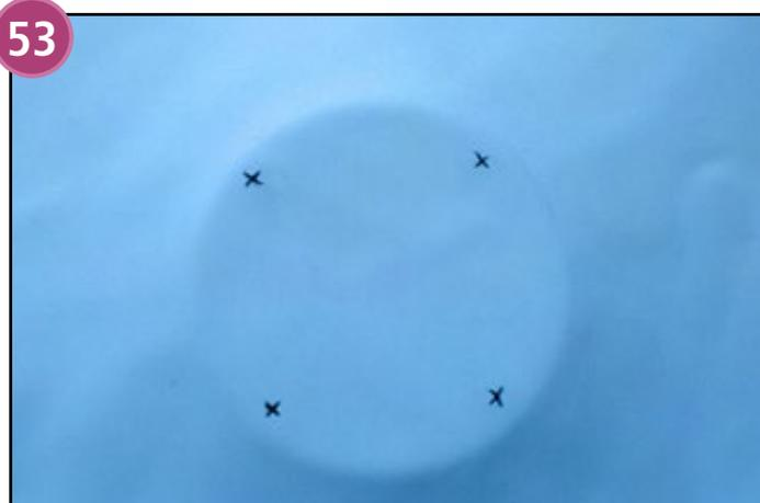
Repérez à travers le liner les quatre points de vissage du corps de buse.
